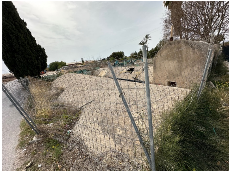
Imagen 7: Depósitos de cabecera del servicio de agua potable. (estado actual)
