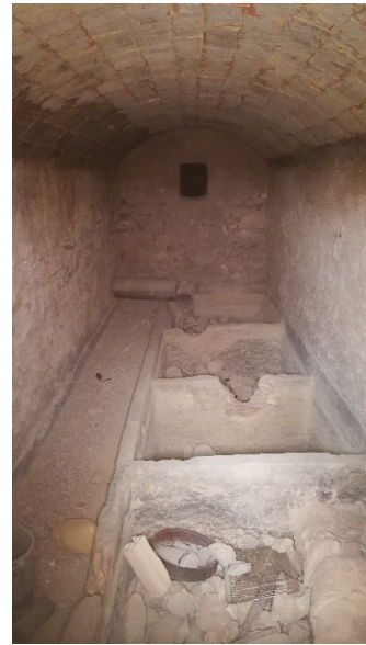
Imagen 4: Interior filtro de agua (estado actual)
