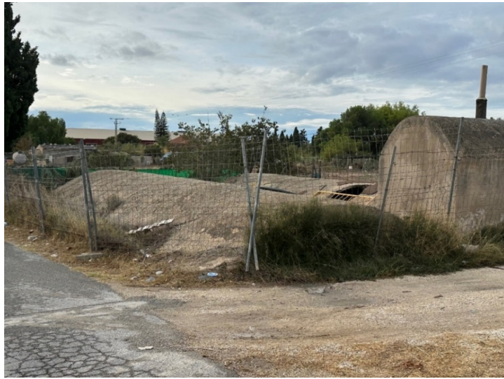
Imagen 6: Depósitos de cabecera del servicio de agua potable (estado actual)
