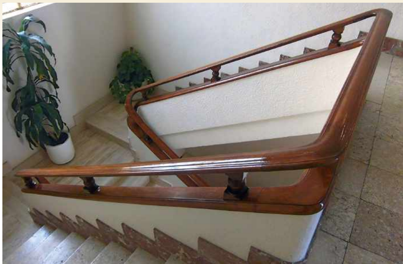
Escalera principal de l'Ajuntament amb el paviment i la barana inicial, que avui dia encara es conserven.
